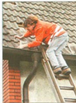
Eichendorffstraße: Hubert Moschner repariert sein Dach selbst.
