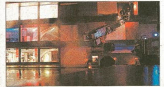
Am Geschäftshaus der Beckhoff Technik & Design GmbH an der Bahnhofstraße hatten sich Fassadenteile gelöst. Die Feuerwehr rückte mit der Drehleiter an. Foto: Elke Hänel
