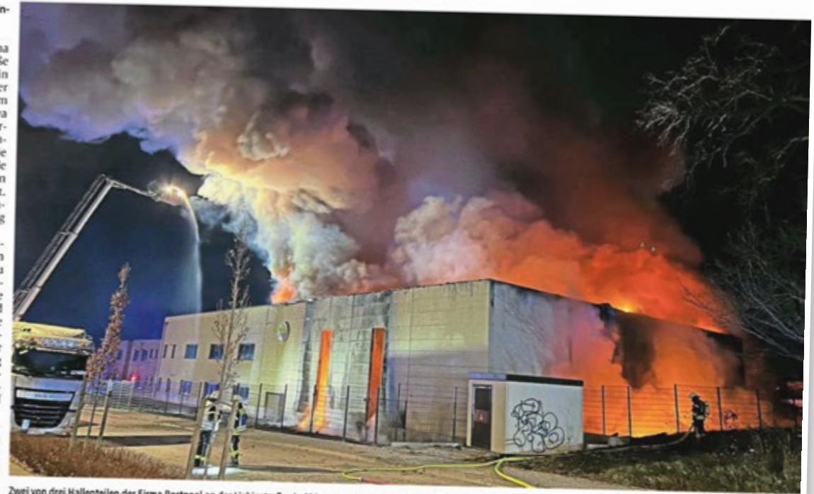
Zwei von drei Hallenteilen der Firma Bestpool an der Liebigstraße sind bis zum späten Abend ausgebrannt und eingestürzt.
