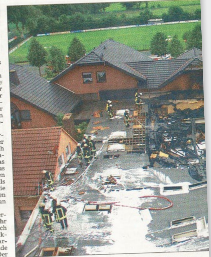
Das ganze Ausmaß der Katastrophe wird von der Drehleiter aus Feuerwehrlaute den Brand durch massiven Einsatz von Löscha...
