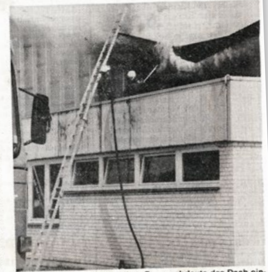
Mit Stangen und Haken haben Feuerwehrleute das Dach eingerissen, um die Brandnester löschen zu können.
