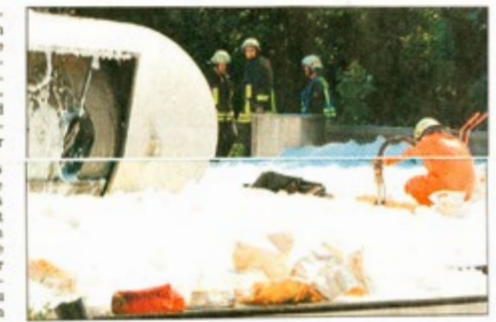
Mit einer Spezialpumpe saugt hier ein Feuerwehrmann den ausgelauenen Diesel und auch das Superbenzin behutsam ab.
