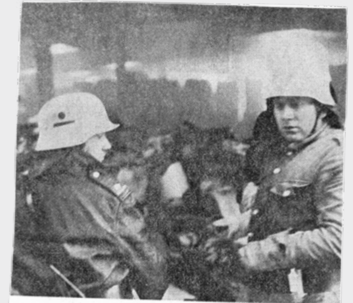
36 Stunden nach Ausbruch des Feuers: Eine Brandwache am Eingang des ausgebrannten Buchbindereilagers bei Mohndruck. Bild: Bitter
