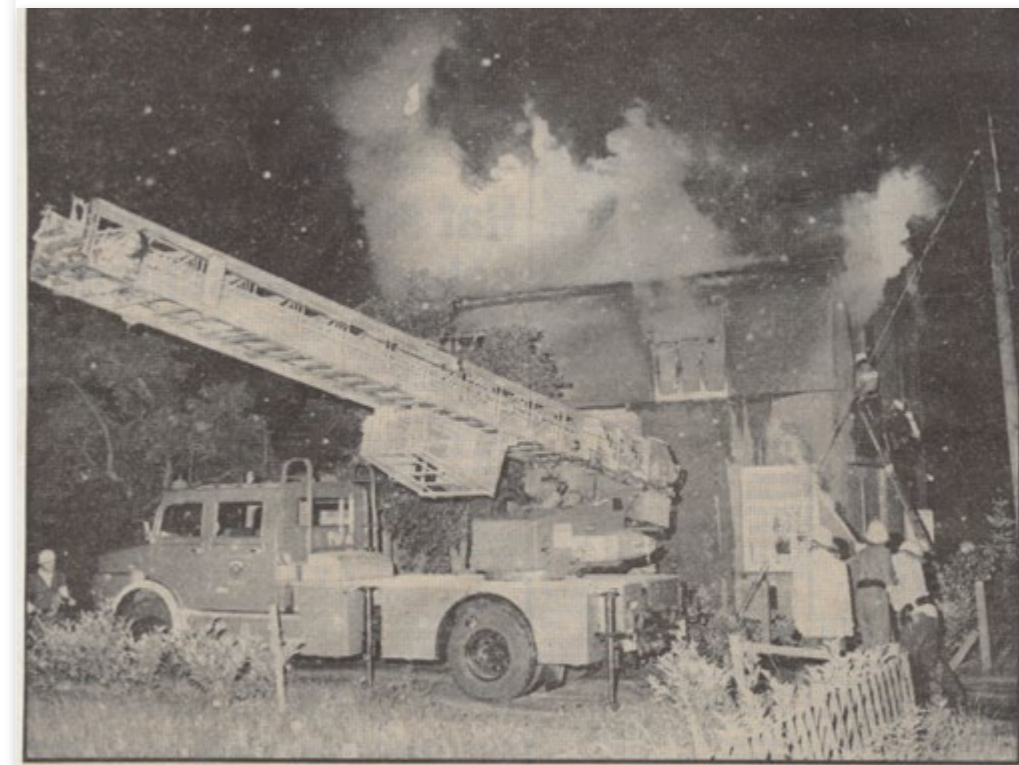
In der Flammenhöhle dieses Einfamilienhauses in Halle-Künsebeck (Kreis Gütersloh) starben in der Nacht zum Samstag sechs Menschen. Vier weitere Bewohner des Hauses konnten sich leicht verletzt ins Freie retten. Alle Fotos: teutopress
