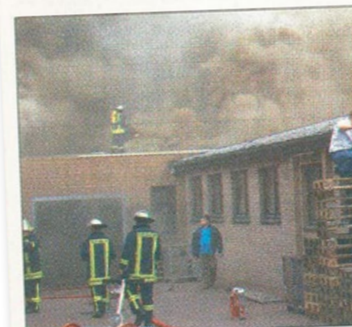
Vermutlich durch Dacharbeiten wurde der Brand entfacht.
